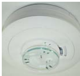
Hitzewarmer Ei603TYC-D mit 10-Jahres-Lithiumbatterie. Quelle: EiElectronics
